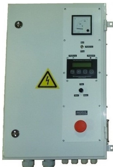
Рисунок 3.1 Внешний вид выпрямителя
