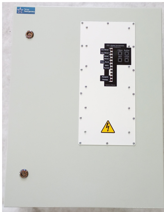
Рисунок 3.1 Внешний вид ШАВР
