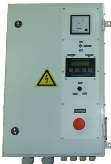
Рисунок 3.1 Внешний вид выпрямителя
