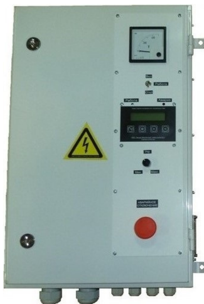
Рисунок 3.1 Внешний вид выпрямителя
